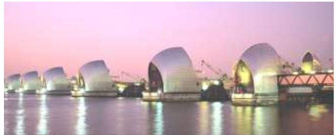
La structure s'étend sur 520 mètres de large et est constituée de 10 portes en forme de secteur angulaire de 20 mètres de haut. Chaque porte est totalement effacée dans un berceau en béton coulé au fond de la rivière. En cas de montée des eaux, les portes pivotent en position verticale actionnées par une machinerie hydraulique.
